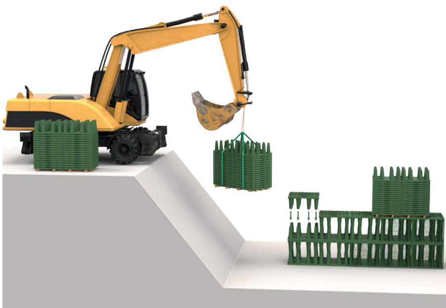
Montage dans la fouille
